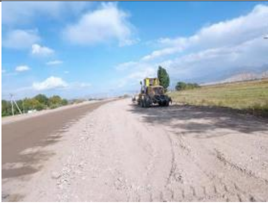
Фото 26. Планировка саббейс материала км 69+000-69+400 LHS
