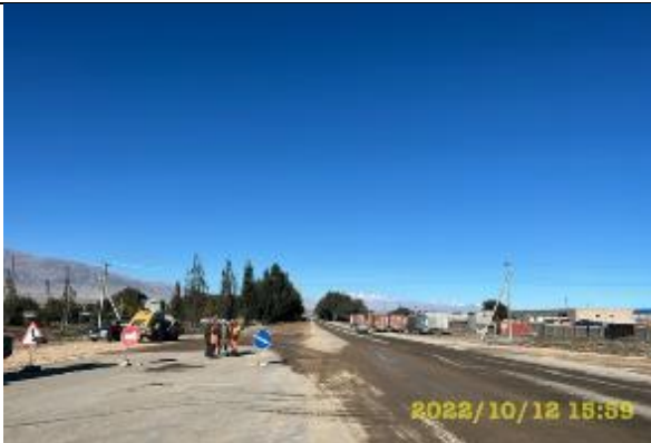
Фото 60 Лот 1. Полив грунтовых участков дороги км. 03+200.
