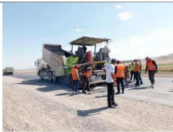
Фото 33. Устройство ЩМА км 79+600-80+100 RHS.
