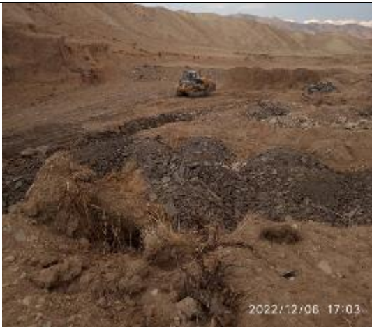
Фото 74. Планировка отвала старого асфальта на км 89+500
