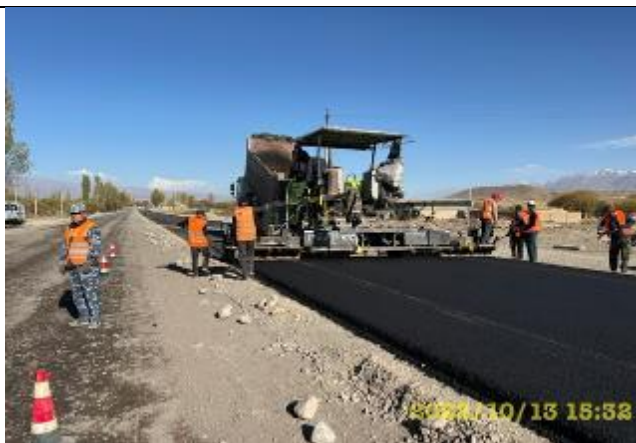
Фото 32. Укладка биндер слоя км 87+100
