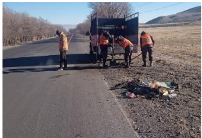
Фото 75. Сан.очистка территории проектной дороги
