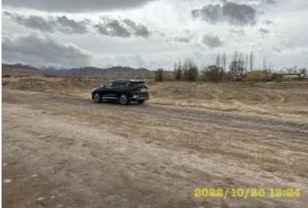
Фото 78. За объездной дорогой рекультивированный отвал непригодного грунта, расположенного на км.65+520
