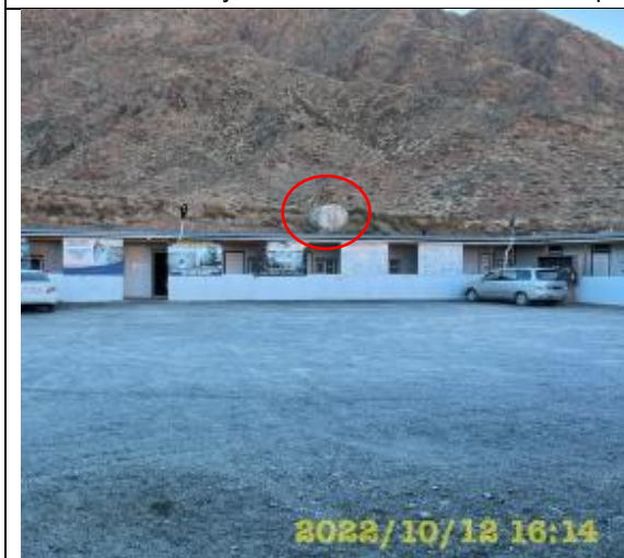
Фото 45. Резервуар бытового водоснабжения (встроенный).
