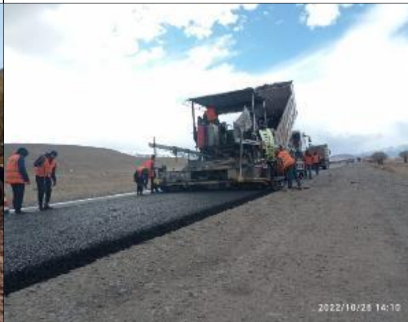
Фото 31. Устройство ЩМА км 81+675-82+000 RHS.
