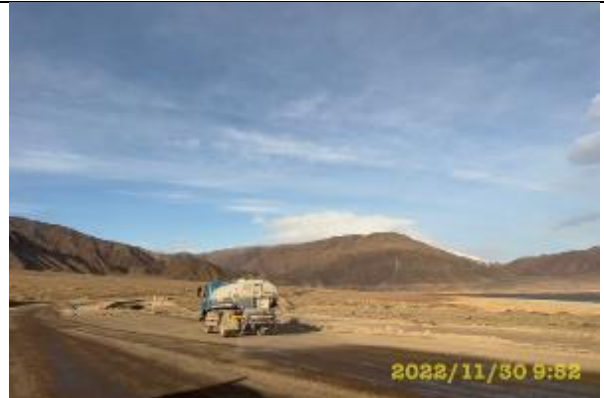
Фото 65. Лот 1. Полив грунтовых участков дороги км. 32+350
