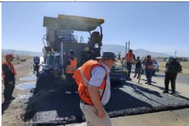
Фото 21. Укладка ЩМА с 3+140 LHS
