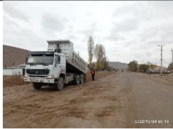
Фото 27. Отсыпка сабгрейд материала (2 слой) км 69+820-70+400 LHS
