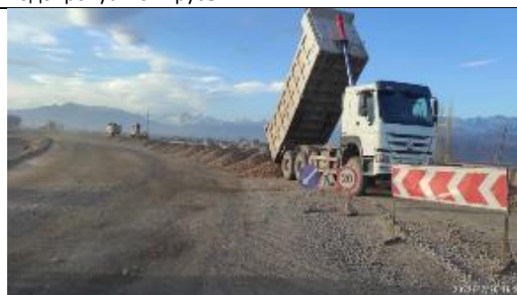
Фото 25. Отсыпка 3 слоя насыпи 65+520-65+620
