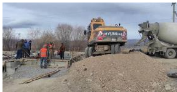
Фото 35. Заливка бетона переходной плиты 1 км 68+044
