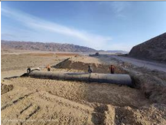
Фото 13. Обратная засыпка трубы 3 слой на км. 40+811
