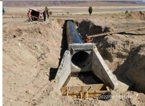
Фото 14. Завершено установка и гидроизоляция водопропускной трубы на 37+161
