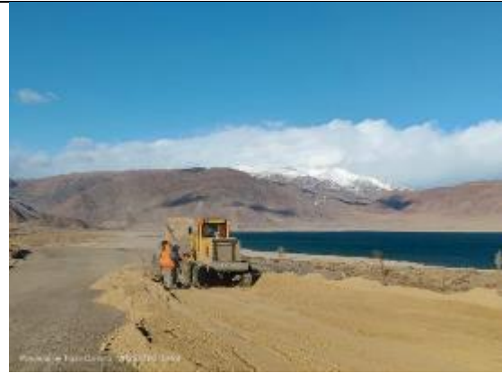
Фото 12. Отсыпка и планировка насыпи на участке км.36+000-36+500 RHS
