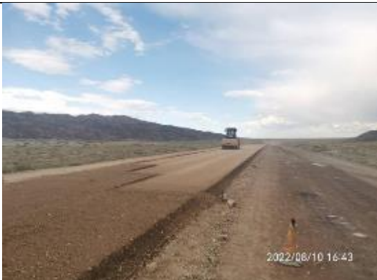
Фото 17. Устройство слой бейс км 33+000 - км 33+340 RHS.
