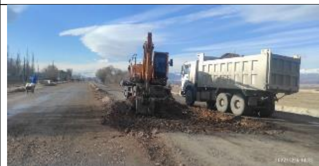
Фото 24. Кирковка существующего дорожного покрытия на км 65+980 - км 66+220.
