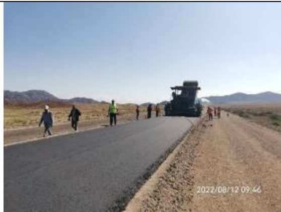
Фото 20. Укладка биндер слоя на км 17+230 - км 17+500.
