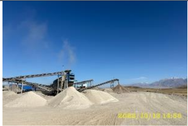
Фото 73. КДУ в работе
