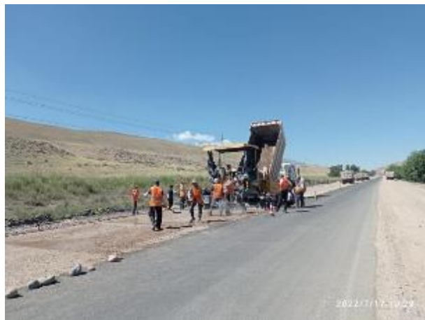
Фото 28. Укладка бейс материала км 85+248 RHS
