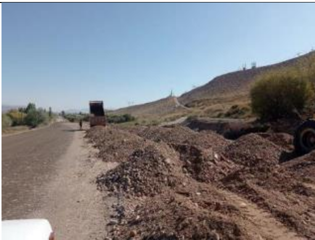
Фото 30. Отсыпка сабгрейд материала км 71+160-71+500 LHS.
