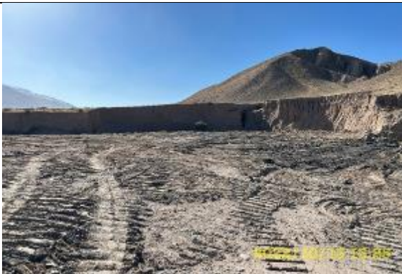
Фото 80. Планировка отвала старого асфальта, расположенного справа от дороги на км. 89+093
