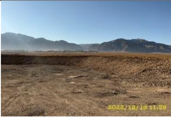
Фото 64. Произведенная техническая рекультивация карьера, расположенный на км.26+800 LHS.
