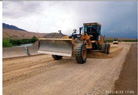
Фото 16. Укладка нижнего слоя основания км 11+320-11+380
