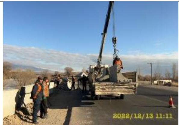
Фото 67. Установка парапетов на Лот 1
