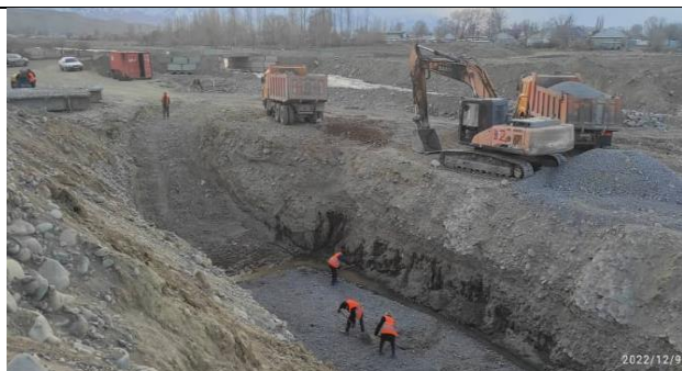
Фото 34. Строительство моста на км 65+410. Устройство основания под фундамент опор моста
