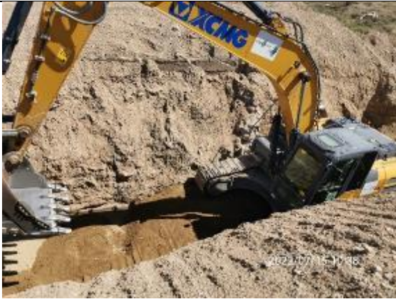
Фото 11. Эскавация трубы на км 22+575
