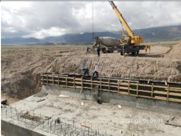
Фото 15. Заливка бетоном стенки трубы на км.22+255
