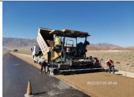
Фото 18. Укладка бейс на участке 21+500-22+000 RHS.
