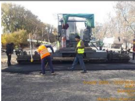
Фото 19 Укладка биндер слоя км 2+100-2+600 LHS
