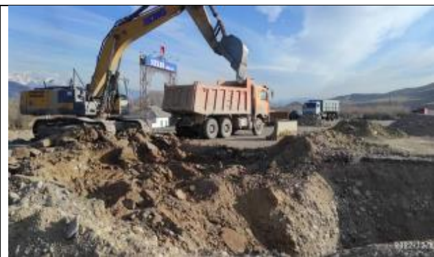
Фото 22. Рытье котлована под строительство подзе пешеходного перехода на км 86+325 RHS
