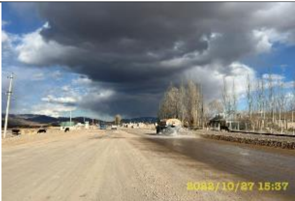
Фото 68. Полив грунтовых участков дорог для предотвращения пыли.
