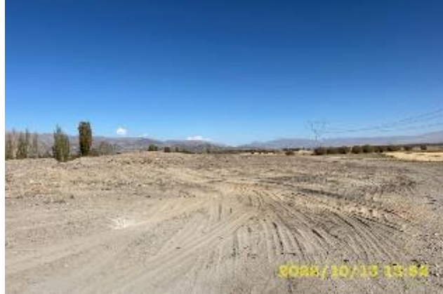
Фото 79. Рекультивированный отвал старого асфальта., расположенного на км 70+180, слева от дороги
